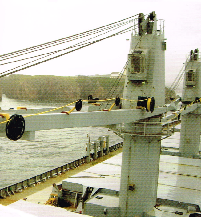
Stromzuführung am Ausleger eines Bordkranes Power supply on deck crane boom
